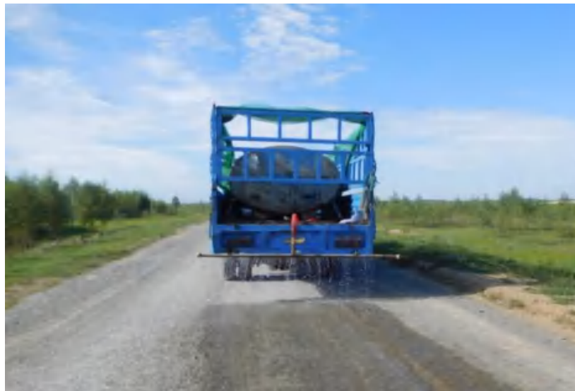
图 5.1-5 施工道路洒水降尘
