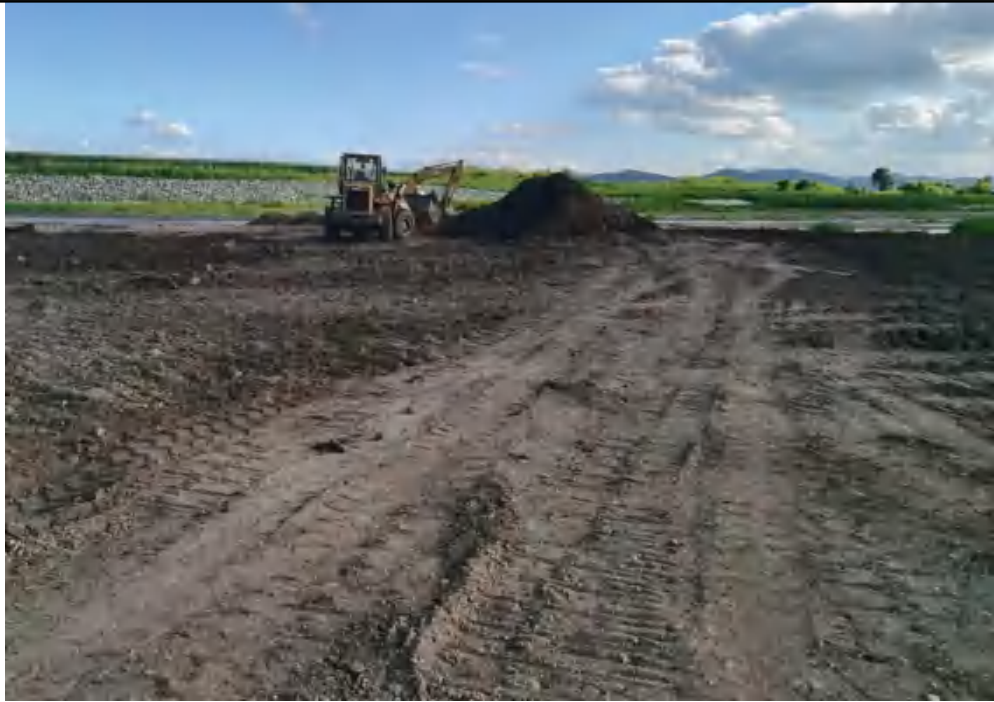
图 5.1-3 施工区土地平整及表土回填
