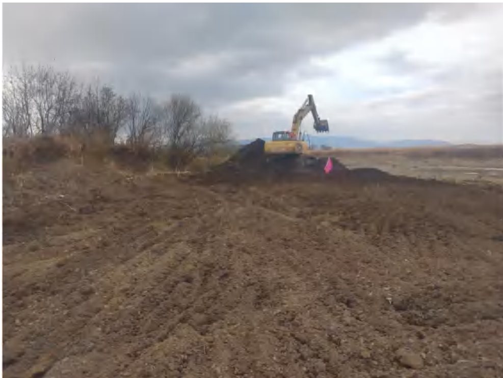
图 5.1-2 施工区表土剥离
