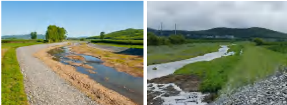
图 4.1-2 工程建成后现场图
