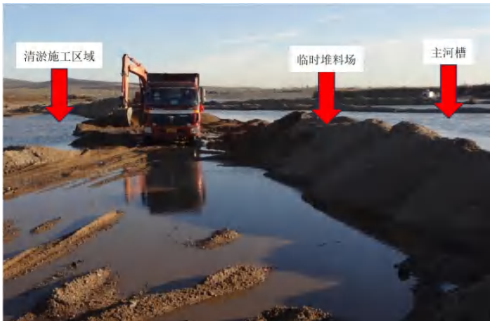
图 4.1-1 清淤工程施工现场图
