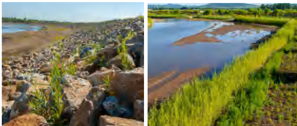
图 4.1-2 工程建成后现场图
