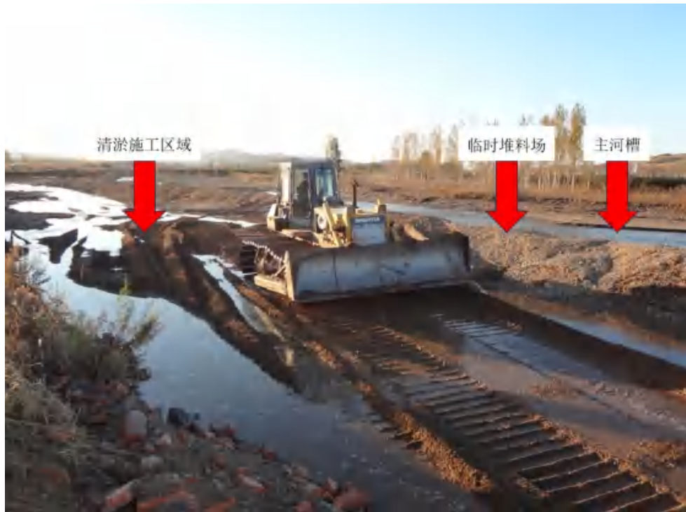
图 4.1-1 清淤工程施工现场图
