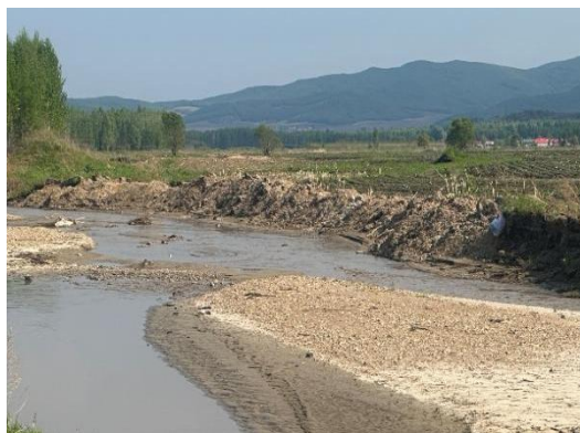
小梨树沟河现状
