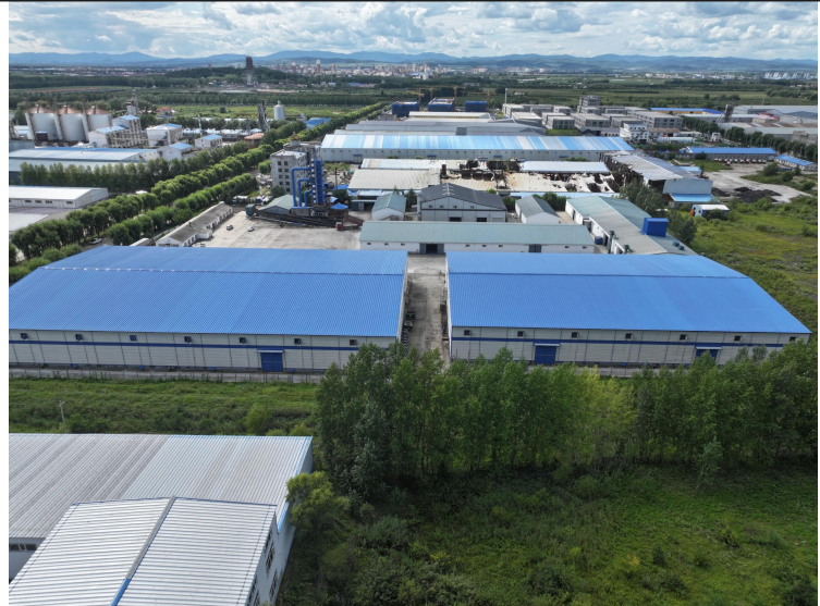
厂界西侧工业厂房
