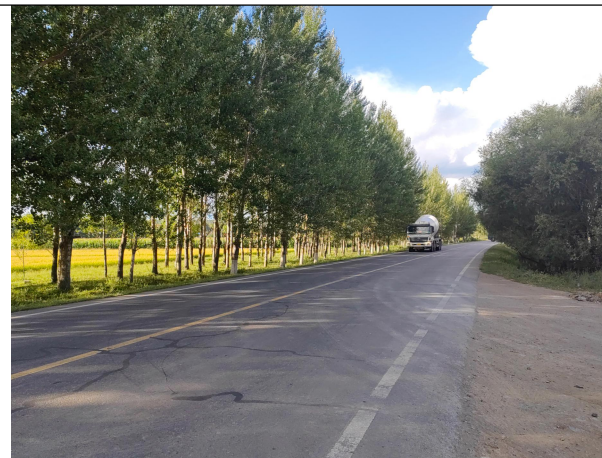
西侧国道 G501（二级公路）
